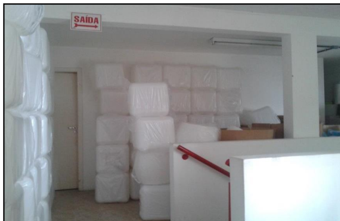
Figura 2: Armazenamento de produtos próximo a escada e escritório.
